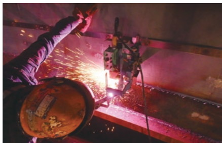
裏ハツリ状況
