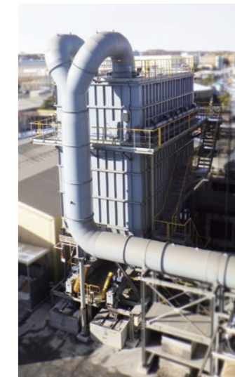
用途：環境集じん (非鉄金属工場) 型式：PD-1008N5-16s-TH 処理風量：2,433m 3 /min
