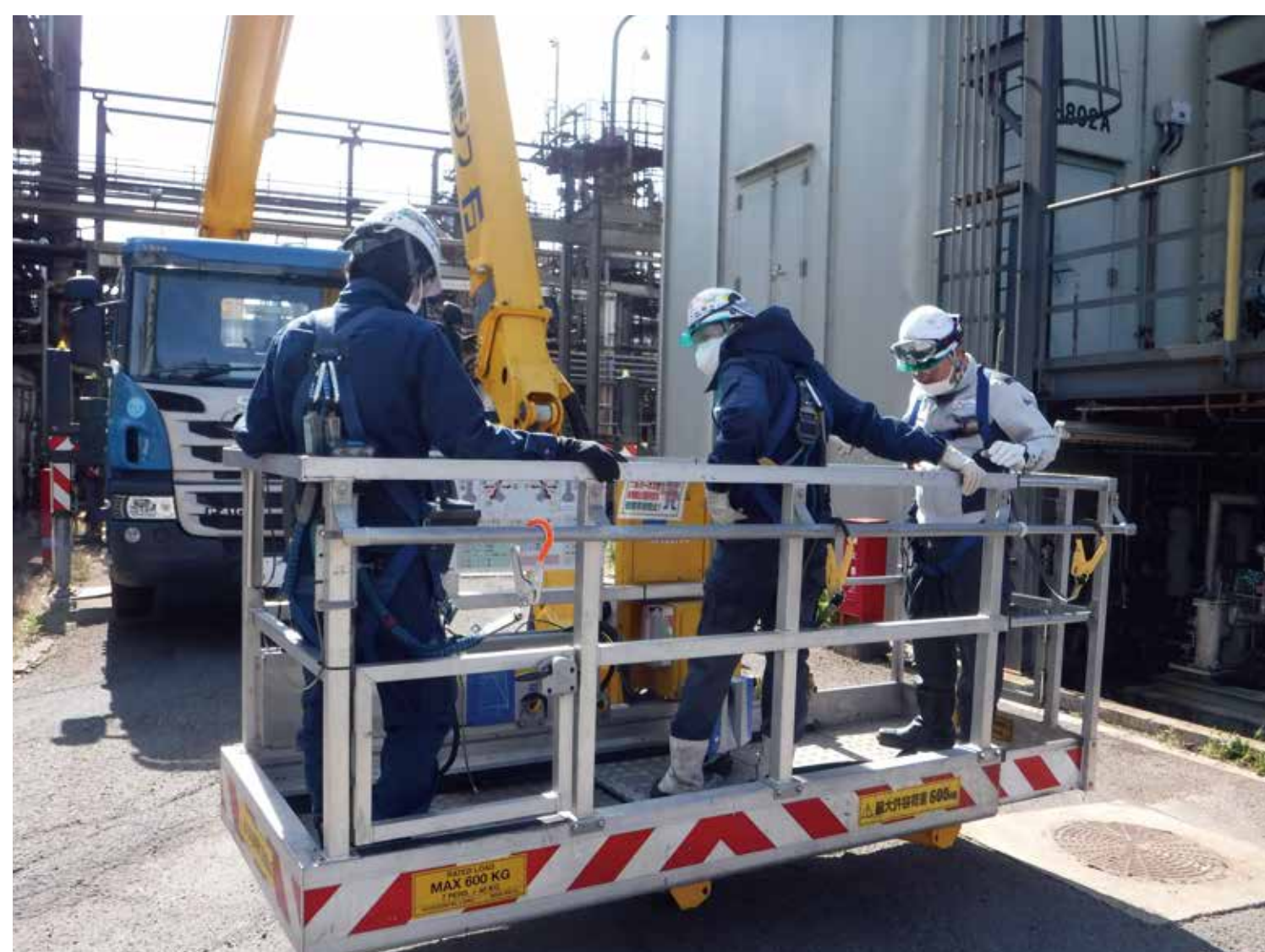
高所作業車によるベントスタックのレーザー計測作業
