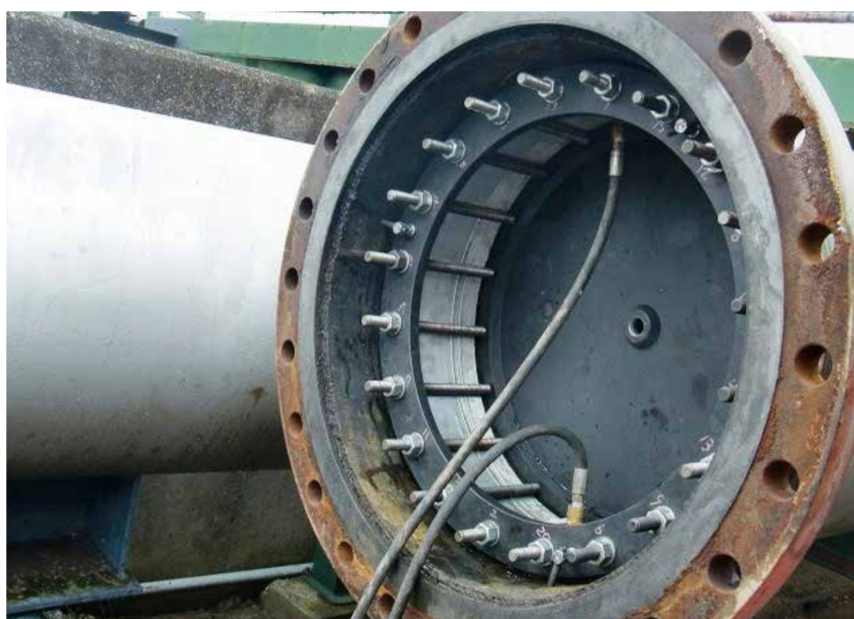
部分耐圧テスト工法
