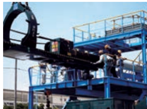
屋外実技ワークショップ(本社)での熱交換器作業訓練
