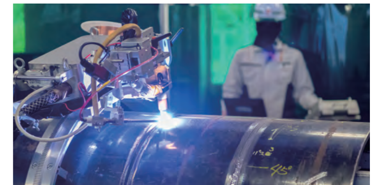
配管自動溶接の試験研究
